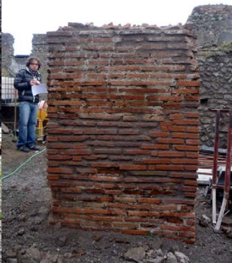
Amb. 69: muratura dopo il restauro
