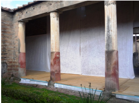
Protezione apparati decorativi durante gli interventi di restauro
