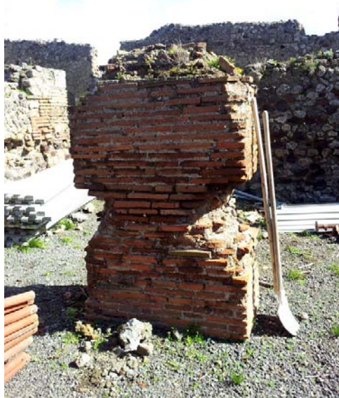
Amb. 69: muratura prima del restauro
