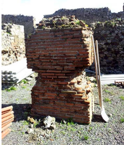
Amb. 69: muratura prima del restauro
