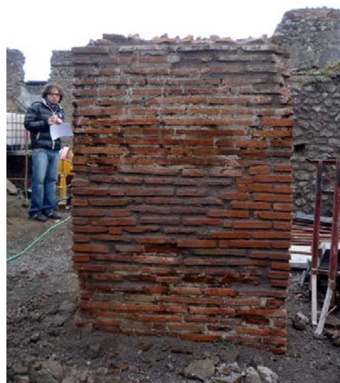
Amb. 69: muratura dopo il restauro
